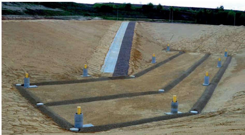
8. Budowa składowiska odpadów w Kobiernikach
