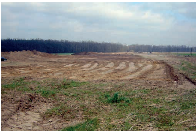
Budowa terminala PGNiG w Wierzbnie
