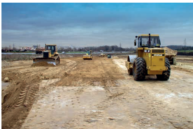
Budowa parkingu - Carrefour Głogów
