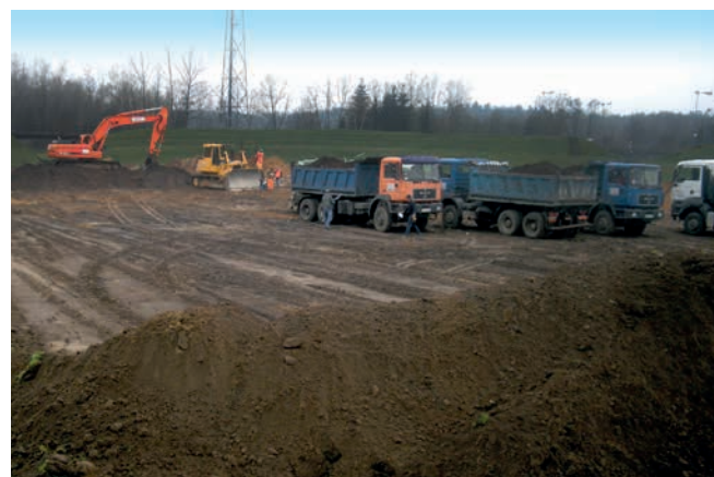
Budowa parkuru - WOSIR Drzonków
