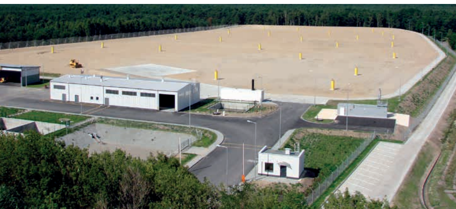
5. Rozbudowa Zakładu Unieszkodliwiania Odpadów Komunalnych w Toruniu
