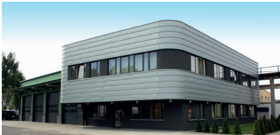
6. Budowa garażu 4 stanowiskowego wraz z zapleczem socjalno-biurowym na Bazie Exalo Centrum w Zielonej Górze
